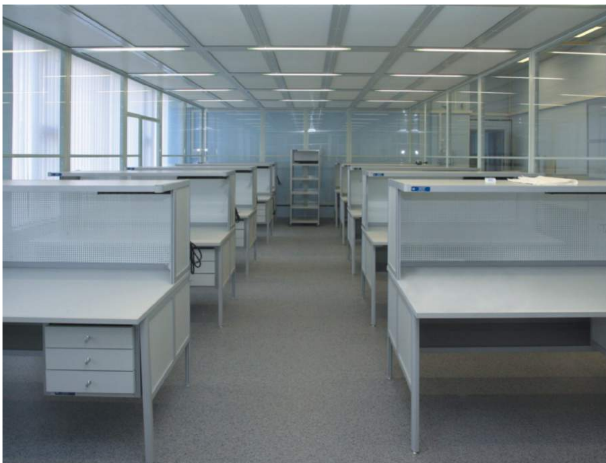
Чистая зона К04 «Ламинар-С». Сборочно-монтажный цех микроплат. Класс чистоты 5 ИСО по ГОСТ ИСО 14644-1. Габаритные размеры комплекса в сборе (ДхШхВ, мм) 8910х4550х2865
